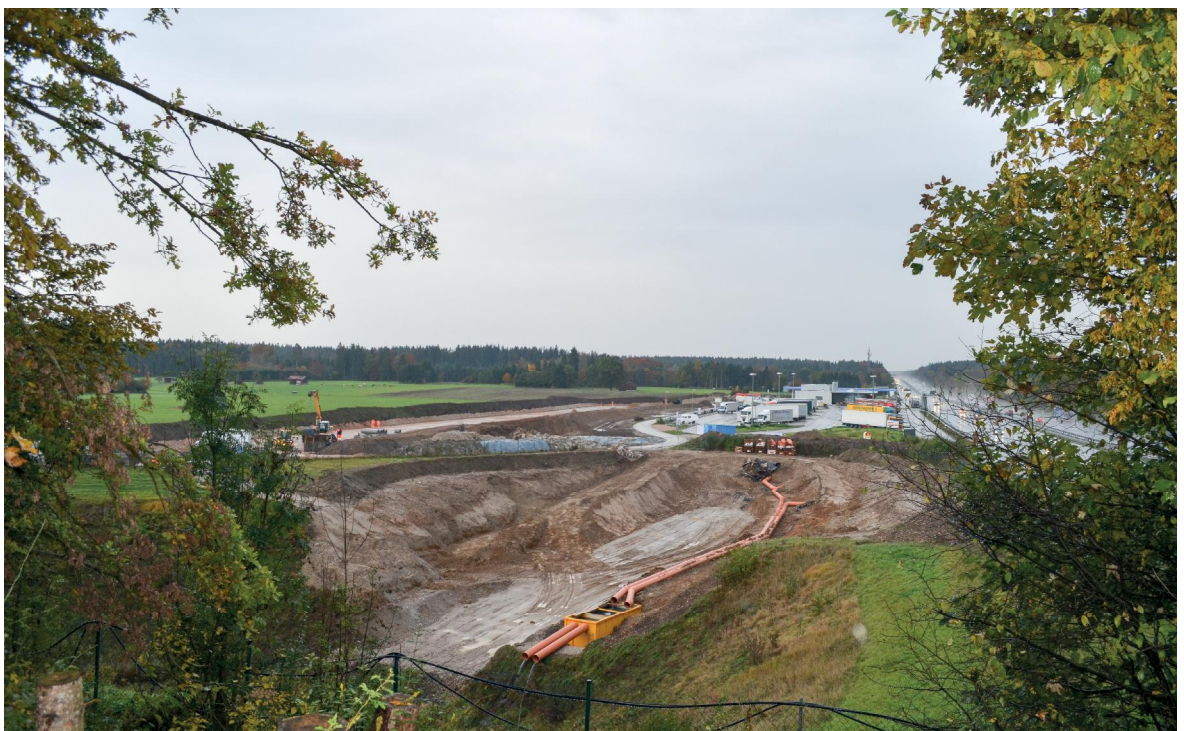
Foto der Baumaßnahme Stand Oktober 2016
